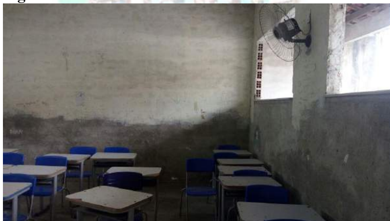
Figura 03: Estrutura da sala
